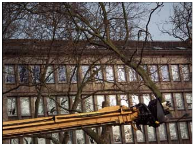
Für die Abholzung wurde großes Gerät aufgeföhren.
